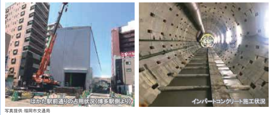
◎地下鉄七隈線延伸工事の進捗状況
