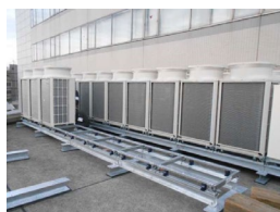
空調設備の更新
