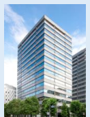
興和西新橋ビル 1996年竣工
