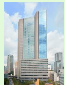
赤坂インターシティAIR 2017年竣工
