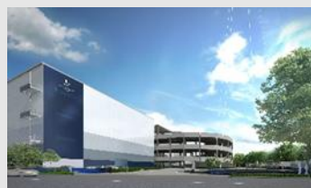
ロジポート加須 2021年7月竣工予定
