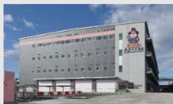
AZ-COM Logistics Kyoto 2020年9月竣工
