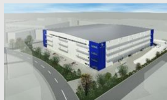
(仮称) 松戸物流センター 2022年1月竣工予定
