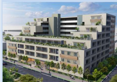
東京科学大学(西蒲田)職員宿舎整備運営事業 東京都大田区 共同住宅(職員宿舎・一般賃貸) 2025年8月竣工予定
