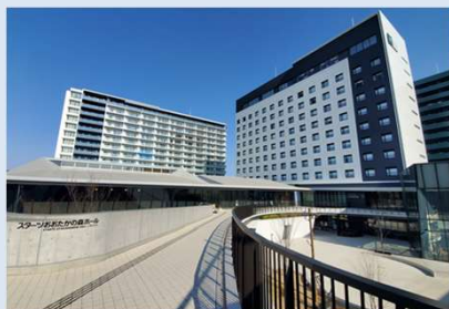
流山おおたかの森駅南有地活用事業 千葉県流山市 公共施設・ホテル・集合住宅 2019年1月開業(ホテル棟) 2019年4月開業(公共施設棟) 2020年3月竣工引渡(集合住宅棟)
