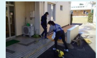
洗浄作業の様子
