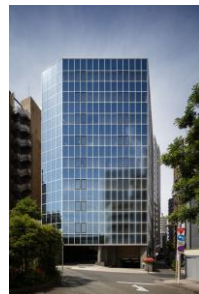
(JPR麹町ビル)
