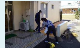
洗浄作業の様子
