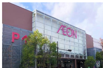
外壁塗装工事
