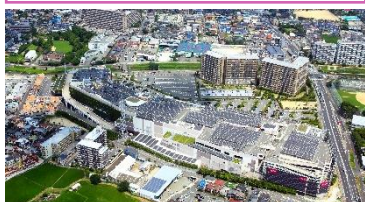
屋上・壁面に太陽光パネルを設置 環境負荷を低減
