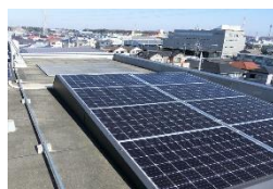
太陽光パネル設置 (夢眠おのみやきた)
