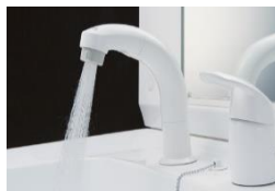
洗面器具の更新 (ジョイ尾山台)
