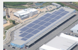
IIF鳥栖ロジスティクスセンター
