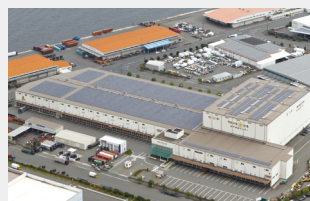
IIF神戸ロジスティクスセンター
