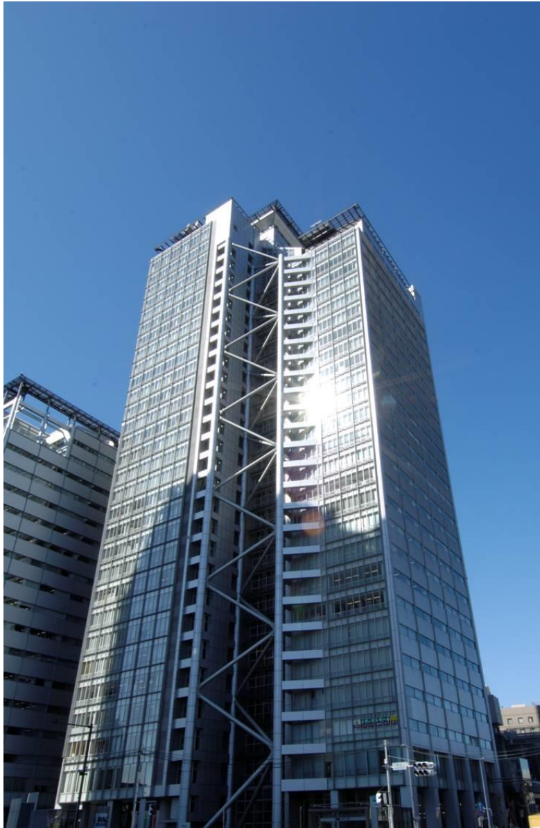
【参考資料2】本物件の外観写真(ツイン棟)
