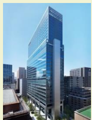
フォワードストローク アーバンネット 内幸町ビル 延床面積: 36,145.48㎡
