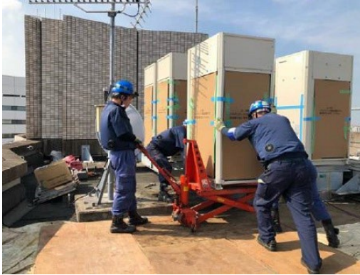
空調設備の更新 (コートヤード・バイ・マリオット 新大阪ステーション)
