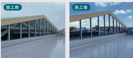
パークプレイス大分フードコートトップライト部遮熱シート施工
