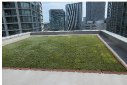
横浜プラザビル(屋上部分)
