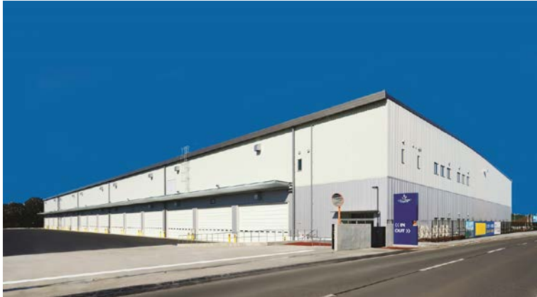
ロジポート狭山日高（埼玉県日高市大字下大谷沢字宮ノ前 85 番 1）
