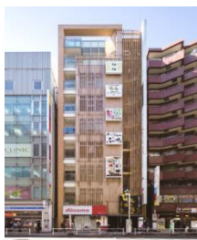
C-1 小滝橋パシフィカビル
