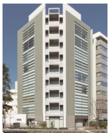
A-59 友泉東日本橋駅前ビル
