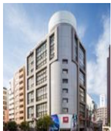
A-42 サンワールドビル
