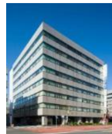
A-39 イトーピア清洲橋通ビル
