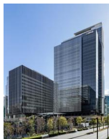
横浜シンフォステージ 2024年竣工
