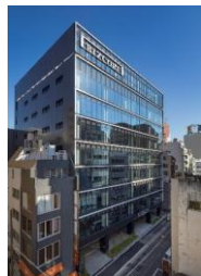
BIZCORE神保町 2017年竣工
