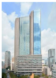
赤坂インターシティAIR 2017年竣工
