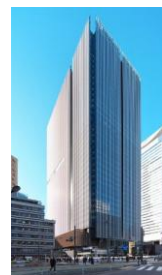
虎ノ門アルセアタワー 2025年竣工
