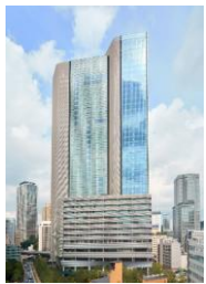
赤坂インターシティAIR 2017年竣工
