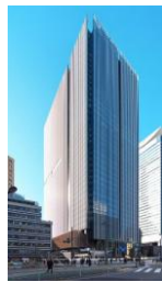
虎ノ門アルセアタワー 2025年竣工
