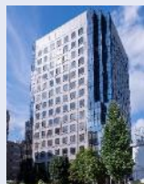
大崎MTビル
