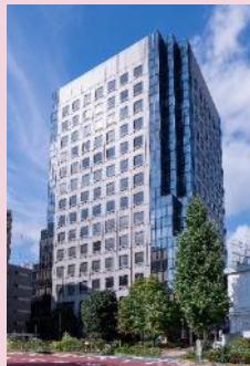
大崎MTビル
