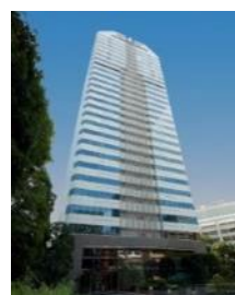
紀尾井町ビル
