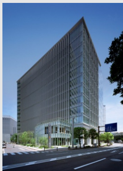
横浜プラザビル
