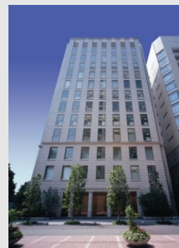
淀屋橋フレックス タワー
