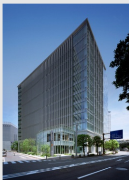
横浜プラザビル
