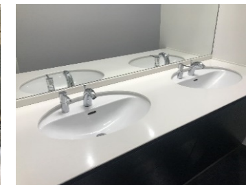
トイレ内洗面を自動水栓に更新 (水使用量年間1,347㎡削減)
