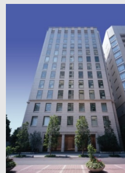
淀屋橋フレックス タワー
