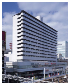
防災盤改修工事の実施 (北野阪急ビル)
