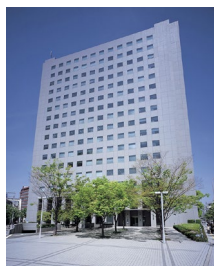
乗用エレベーター改修工事の実施 (阪急電鉄本社ビル)
