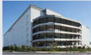
ロジポート尼崎 2017年10月 コンバージョン完了
