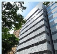
新横浜センタービル ★★★
