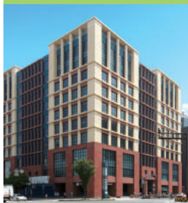
呉服町ビジネスセンター
