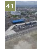
41 小田原機材管理センター(底地)
