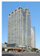
日石横浜ビル
