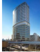
浜離宮インターシティ
