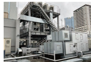
空調設備の更新 (Daiwa赤坂ビル)
