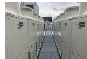
空調設備の更新 (Daiwa銀座ビル)
