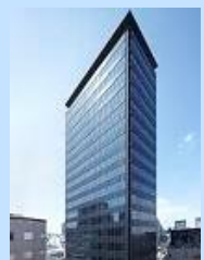
アーバンネット 神田ビル 延床面積：14,724.77㎡
