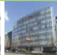
天神ノースフロントビル
