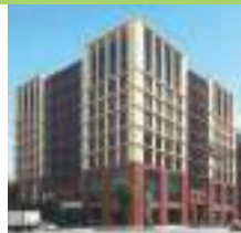
呉服町ビジネスセンター
