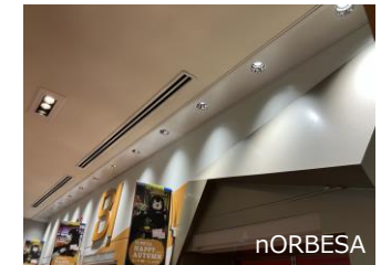
LED化工事後の様子
