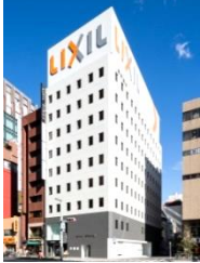
事A-19 東京建物京橋ビル
