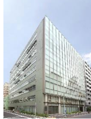
事A-20 JPR日本橋堀留ビル
