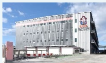
ロジポート京都 2020年9月竣工
