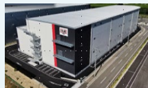
愛西案件 2021年7月竣工
