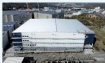
ロジポート神戸西 2021年11月竣工
