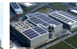
M-03 プロロジスパーク川島 M-20 プロロジスパーク川島2
