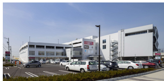
北面都市計画道路より
