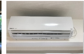
省エネ型エアコン設置 (TKフラッツ渋谷)
