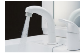
洗面器具の更新 (ジョイ尾山台)
