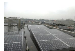
太陽光パネル設置 (みんなの家・大宮つつじが丘公園)
