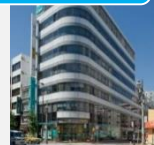
ヒューリック 東上野一丁目ビル
