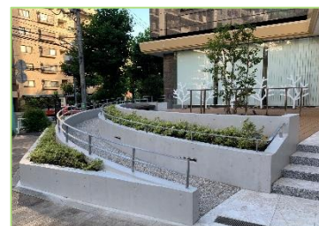
エントランスアプローチにスロープを設置
