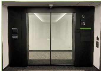
【専有部エントランス セキュリティゲートの設置】
