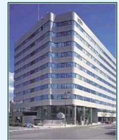
NBFユニックスビル
