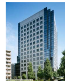
大崎MTビル
