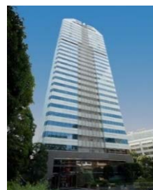
紀尾井町ビル
