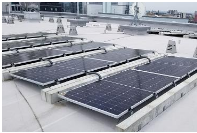
太陽光パネルの設置 (グランカーサさいたま新都心)
