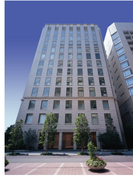
淀屋橋フレックスタワー
