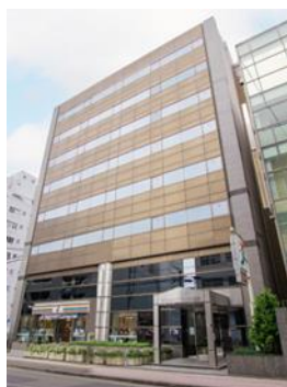
MI テラス仙台広瀬通り
