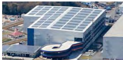
太陽光パネル
