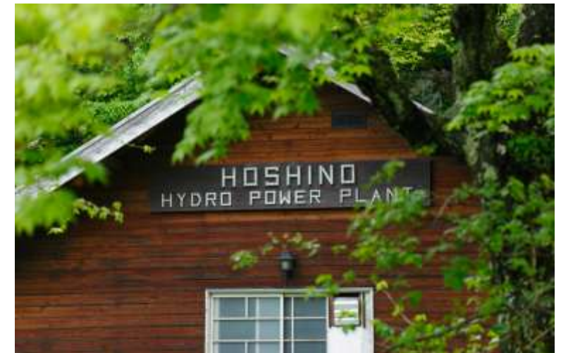
ヒートポンプの動力の一部を賄う水力発電設備
