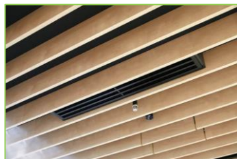
【高性能空気清浄機の設置】
