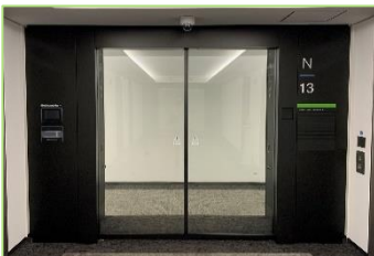
【専有部エントランス セキュリティゲートの設置】
