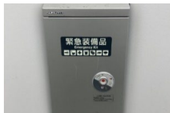
防災備品の設置
