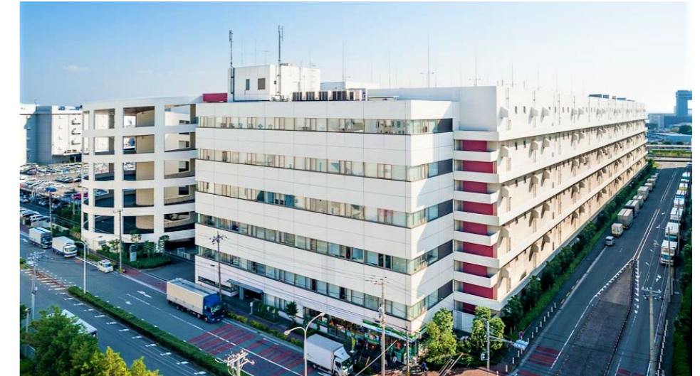
ロジポート東扇島C棟
