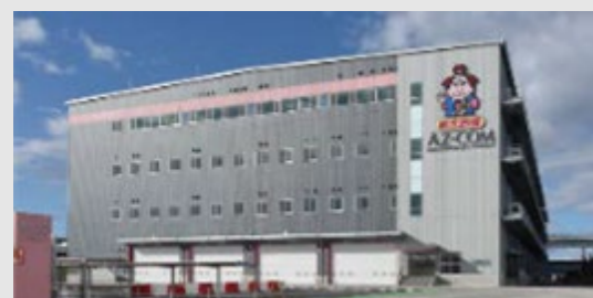
AZ-COM Logistics Kyoto 2020年9月竣工
