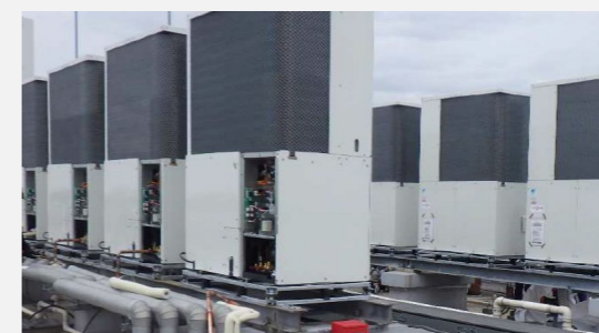
新型空調設備への改修
