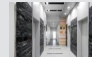
廊下やトイレの照明自 動点滅センサー
