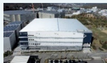
ロジポート神戸西 2021年11月竣工
