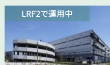
ロジポート加須 2021年7月竣工
