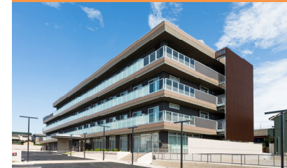
メディカル・リハビリホーム グランド豊田元町 (愛知県豊田市 75室)
